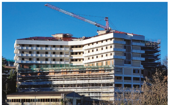
Lavori di ristrutturazione dell'ex Hotel Toscana di Arcidosso (GR), ora del Centro dell'Uomo.
